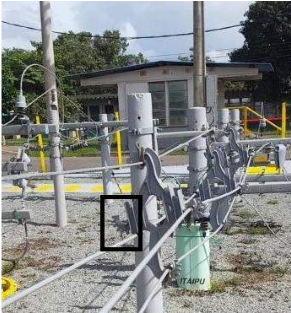
Figura 35 – Cabo fora do Espaçador
