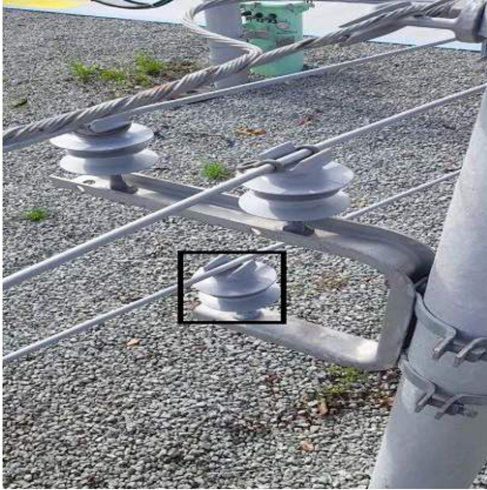
Figura 36 – Isolador sem Anel de Amarração
